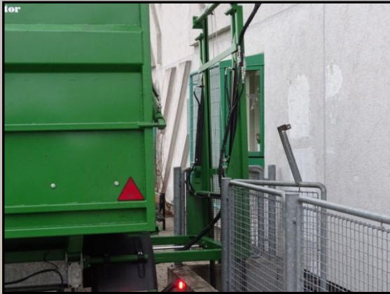
Verschiebung Elevator 100 cm.
